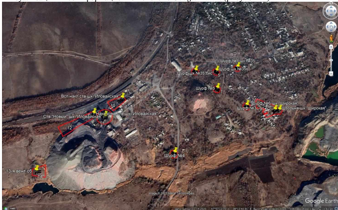
Рисунок 11 – Поле шахты «Иловайская» с горными выработками и провалоопасными зонами, визуализированными в геоинформационной системе Google Earth
